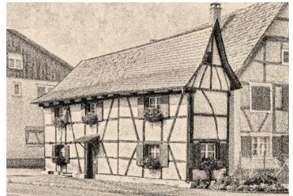
An old house in Blotzheim, Alsace, France http://fr.db-city.com/France-Alsace-Haut-Rhin-Blotzheim
